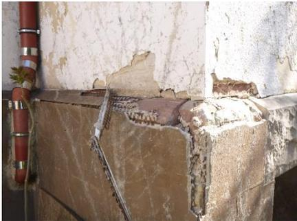
Das Gebäude ist zum Teil als Fachwerk errichtet. Im Vorderhaus ist ein (tragender?) Balken faul. Der Verputz hinter dem Haus hat sich gelöst und ist großflächig abgeplatzt. Wasser läuft zwischen Putz und Mauerwerk, es kommt zu Folgeschäden. Die Fenster im Clubheim und im Flur sind einfach verglast. Der Kitt fehlt, das Holz ist rissig. Es besteht akuter Handlungsbedarf.
