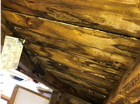
Unsere über hundert Jahre alten Schieferziegel sind brüchig, lösen sich aufgrund Nagelfäule vom morschen Dachgebälk, es regnet bereits seit Jahren hindurch. Auch im Bereich der Rundbogenholzfenster mit Einfachverglasung kommt bei Starkregen wegen fehlendem und bröckelndem Kitt das Wasser durch.
